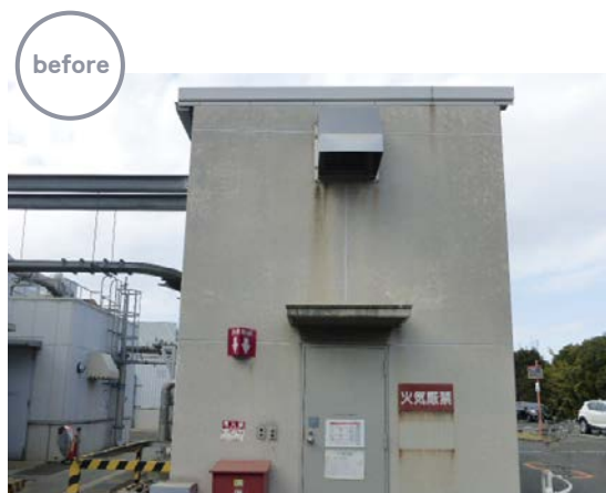
兵庫県 危険物倉庫
