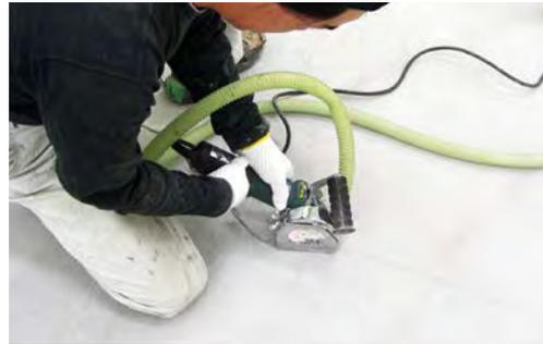
下地処理：欠き込み目地、クラックの補修
