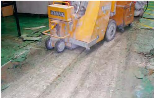
素地調整：旧塗膜の除去および不陸調整
