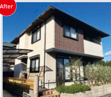
使用塗料：ユーロテックス(外壁)
